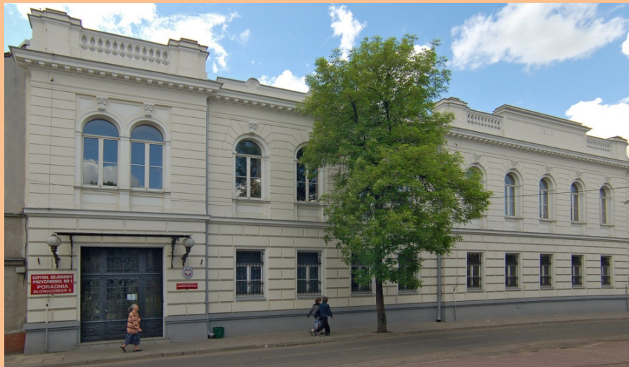
Будівля, в якій Державний архів Пьотркува Трибунальського розміщується з 1939 р.
