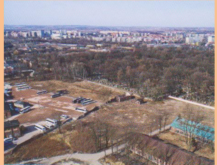
Будівельний майданчик, на якому згодом буде зведено Національний архів давніх актів у Кракові
